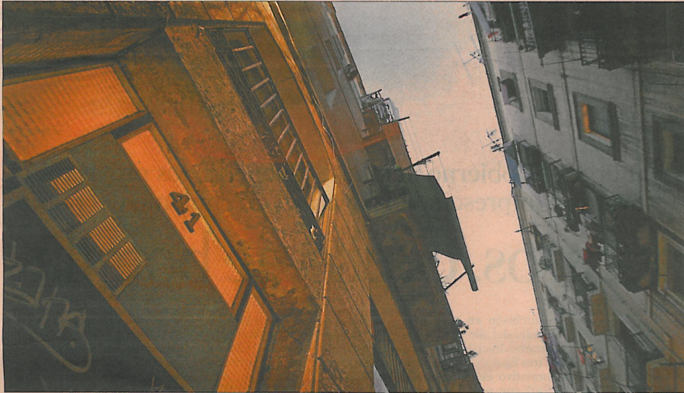
La mayor parte de fincas del barrio del Raval de Barcelona fueron construidas antes de 1970
